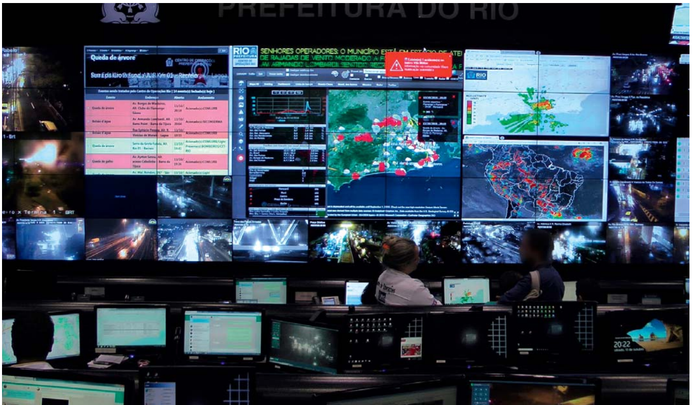
Großer Kontrollraum des Centro Operaciones Rio de Janeiro (COR) am 13.10. 2018 während Alarmstufe 2 und kurz nach Starkregenereignis Quelle: Eigene Aufnahme 2018
